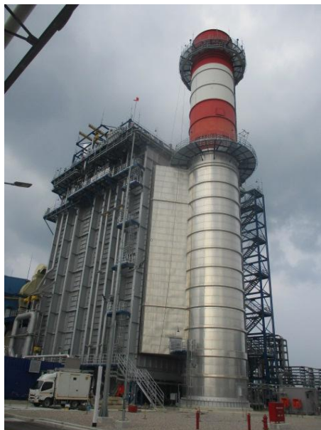
ปล่องระบายมลสารของโรงไฟฟ้า หน่วยการผลิตที่ 2 (HRSG Stack Unit 2)
